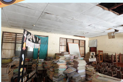
Ruang kelas sebelum renov
