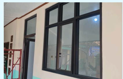
Pintu dan jendela setelah renov
