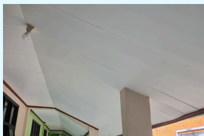
Plafon depan kelas setelah renov
